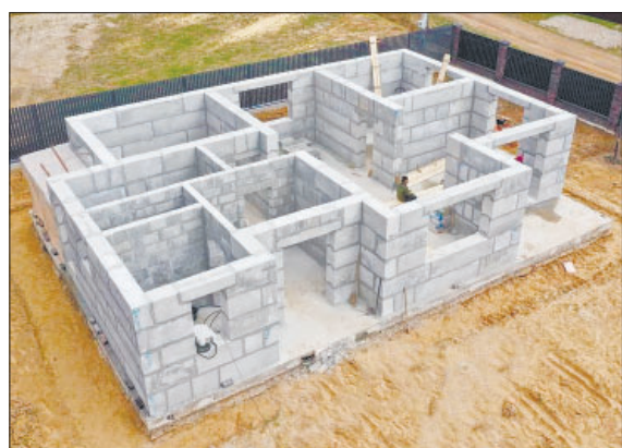
Рис. 4. Строительство дома из крупноформатных полистиролбетонных панелей Fig. 4. Construction of a house made of large-format polystyrene concrete panels
